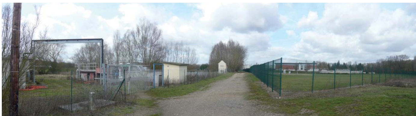
Les installations techniques pour l'épuration de l'eau et l'habituel treillis soudé vert créent un paysage en rupture avec l'image de la campagne, un peu comme un arrière délaissé de la ville.
