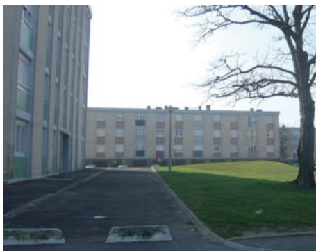
Aménagement minimaliste de la voie d'intervention des sapeurs-pompiers.
