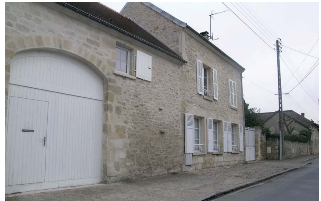
Ancienne ferme de village, dans le hameau de Chaumont
